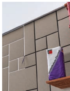
Configurarea îmbinărilor cu lapte de ciment rezistent la apă (ex: protecție flexibilă de brău Baunit)
