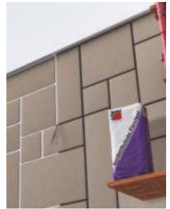
Configurarea îmbinărilor cu lapte de ciment rezistent la apă (ex: protecție flexibilă de brâu Baumit)
