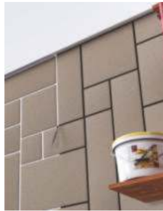
Configurarea îmbinărilor cu vopseaua de exterior
