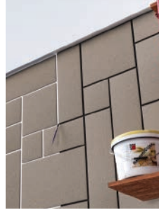
Configurarea îmbinărilor cu vopseaua de exterior
